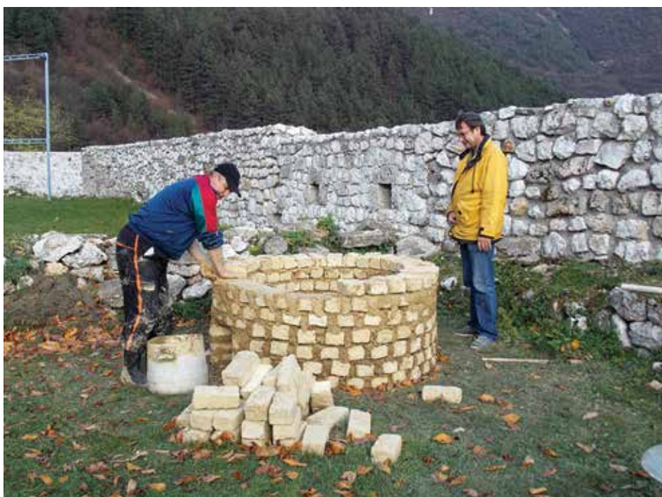
Zidanje lončarske peći na Starom gradu
